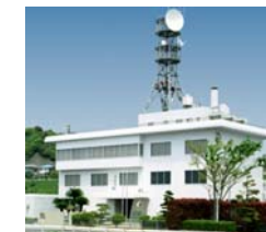
河口堰管理支所
