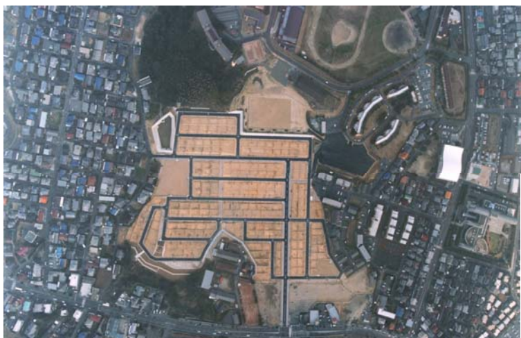
藤原開発工事
