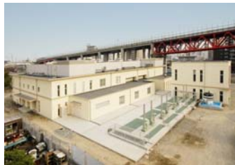
戸畑ポンプ場 上屋 新築工事
