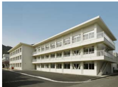
北九州工業高専3号館 改修工事
