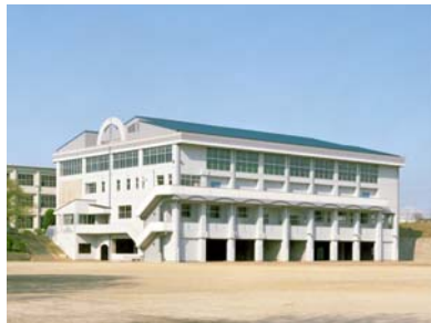
福岡県立八幡工業高校 体育館 新築工事
