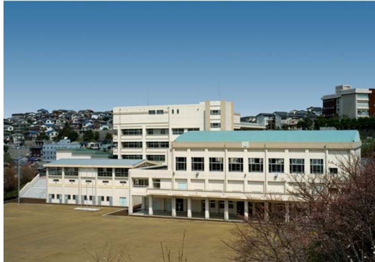
枝光台中学校 新築工事
