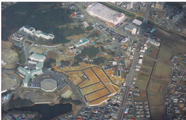
宗像市・自由ヶ丘学園通り 造成工事
