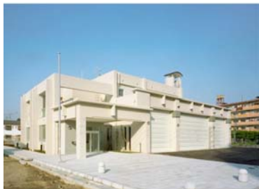
八幡西消防署 折尾出張所 新築工事
