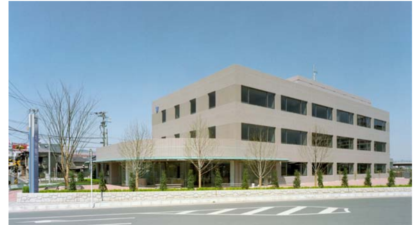
九州電力(株) 田川営業所 新築工事
