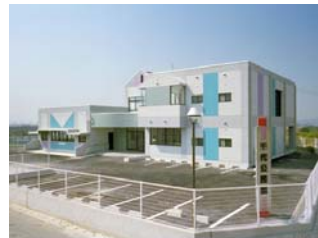
千代公民館 新築工事
