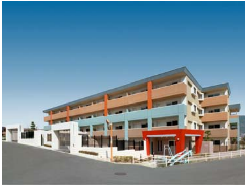
コーボラスレジェンド 新築工事
