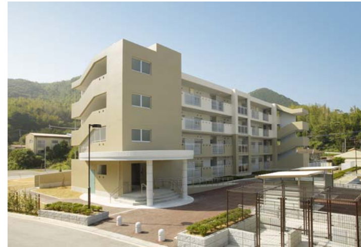
三吉団地 第3工区 新築工事
