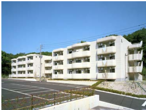
日本大洋海底電線(株) 社宅 新築工事
