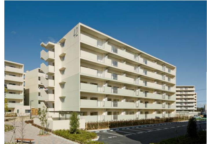
吉田団地 第17工区 新築工事
