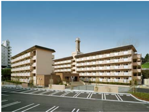
九州厚生年金会館 看護師宿舎新築工事
