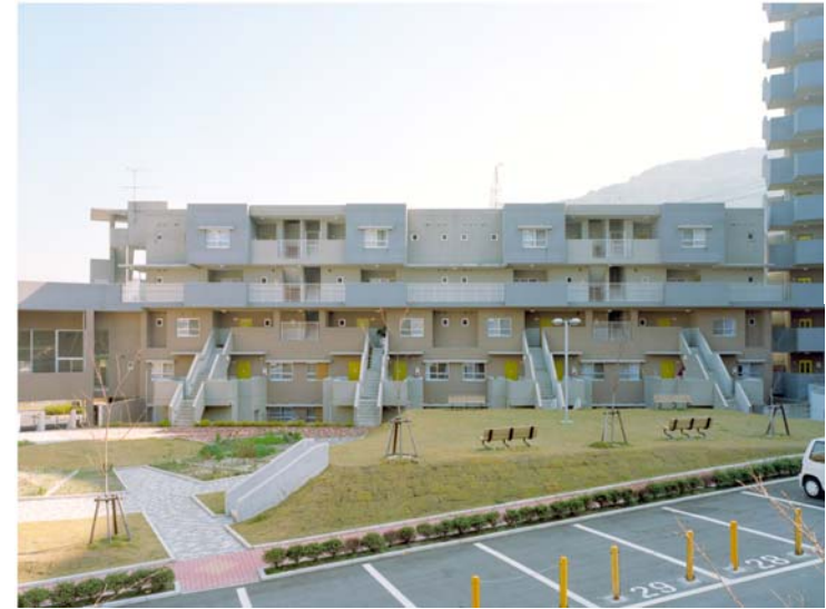
大谷アパート 新築工事
