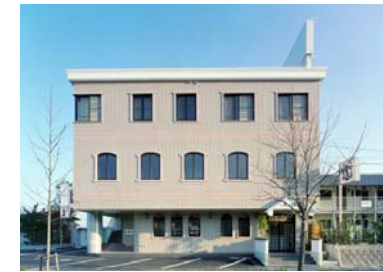
林ビル 新築工事
