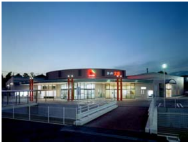
スーパー大栄 香月西店 新築工事
