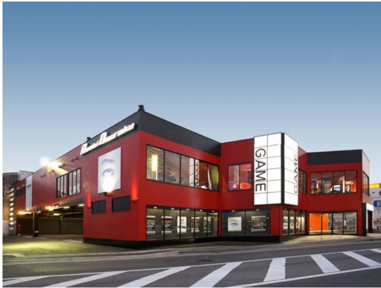
遊道楽 粕屋店 新築工事
