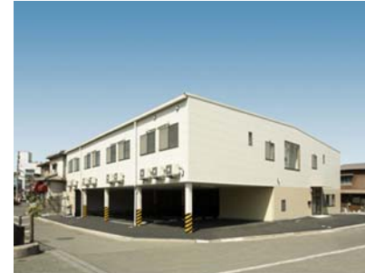
グループホームのむら 新築工事
