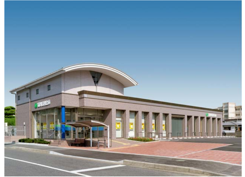
遠賀信用金庫 本店 新築工事
