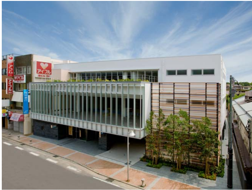
福岡銀行 折尾支店 新築工事
