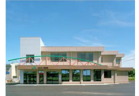
JA北九州 若松支店 新築工事
