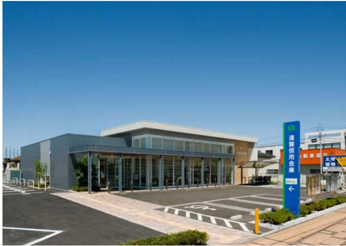
遠賀信用金庫 みやじ参道支店 新築工事
