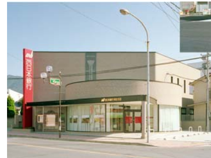
西日本銀行 相生支店 新築工事
