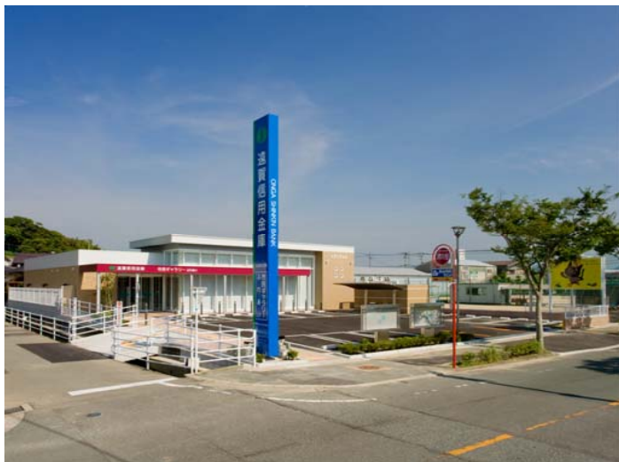
遠賀信用金庫 むなかた支店 新築工事
