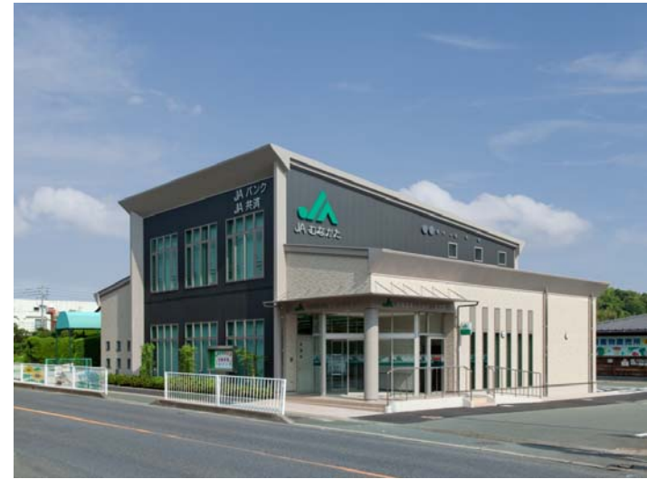
JAむなかた 河東支店 新築工事
